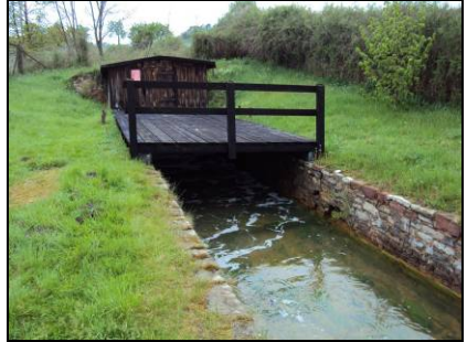
Bild 17: Mundloch des Schlüsselstollns
