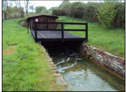
Bild 17: Mundloch des Schlüsselstollns
