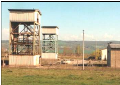
Bild 18: Bohrschächte Brücken I u. II
