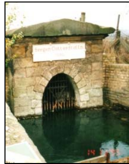
Bild 6: Mundloch des Seegen-Gottes-Stolln
