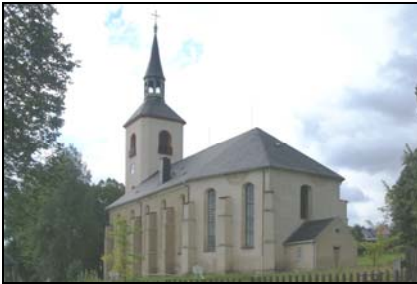
Die Kirchenansicht von außen
