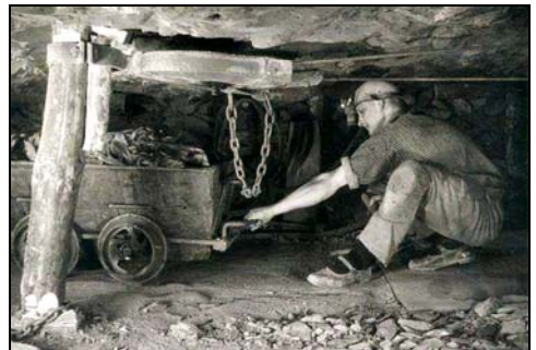
Anschlagen des Huntес an das Endlosseil des „Elektrischen Jungen“
