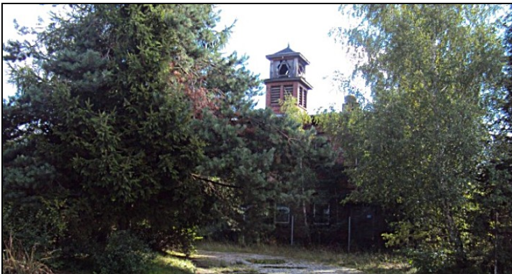
Ehemaliges Küchegebäude des Fortschritt-Schachtes
