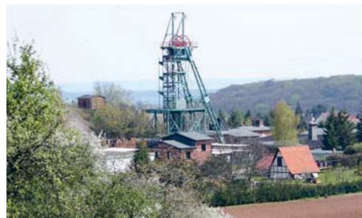
Der Röhrigschacht Wettelrode.
