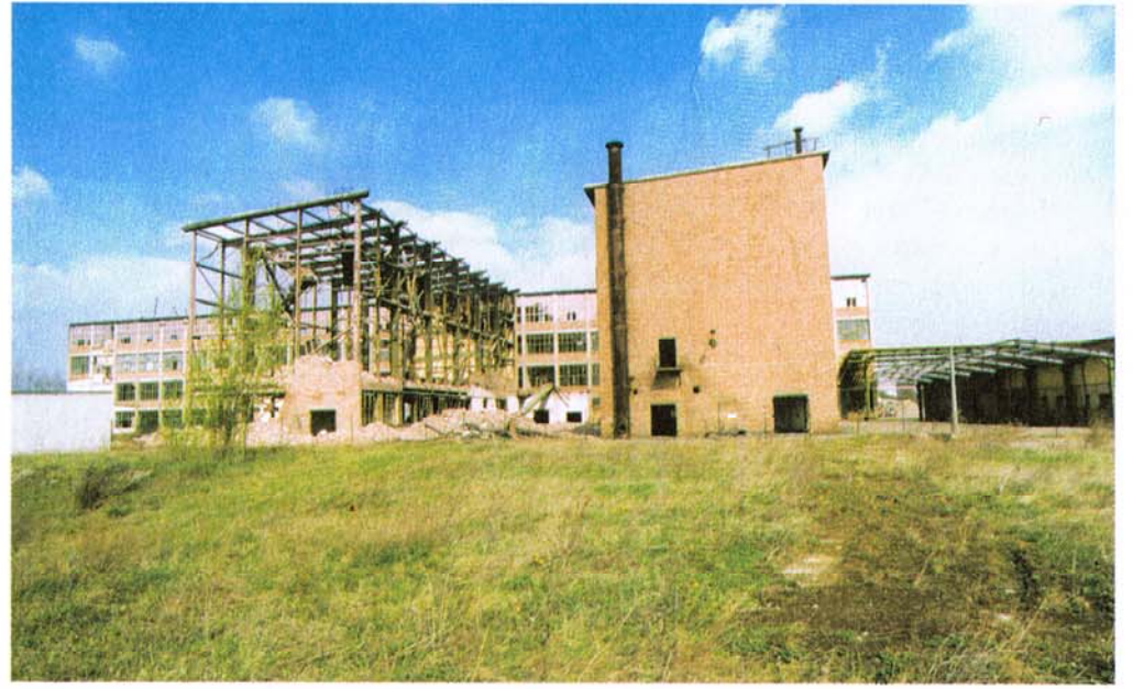
Die ehemalige Lackdrahtfabrik im April 1999.
