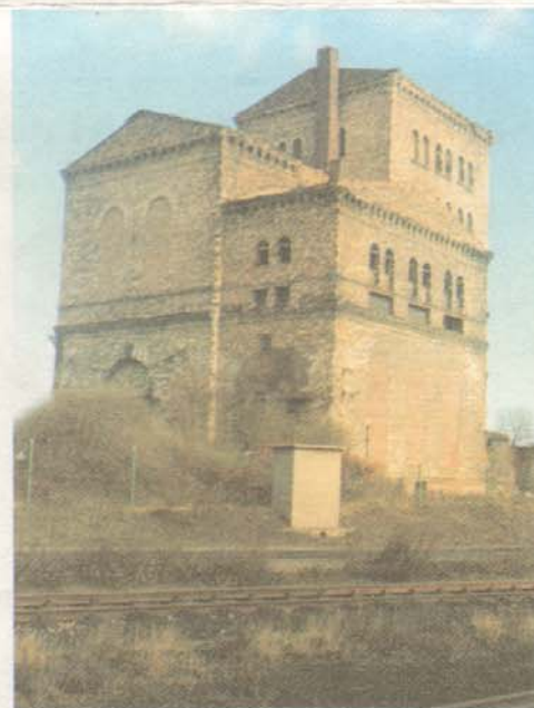
Gebäude des Wasserhaltungsschachtes Ernst-Schacht IV in Helbra.
