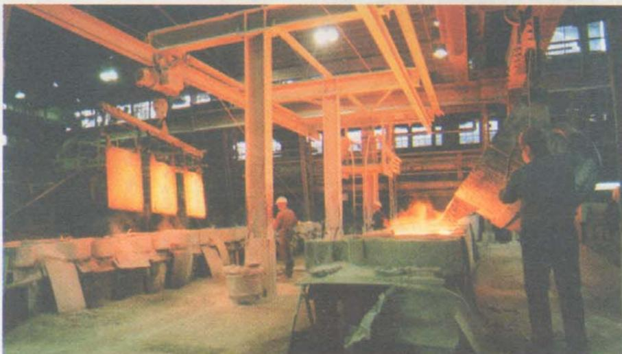
Wie von Anbeginn an: aus vom Kran getragenen Gießkübeln wurden im manuellen Flachguß die Anoden in kupfernen Formen gegossen. Die Entnahme der Anoden erfolgte mittels Gehängezug.
